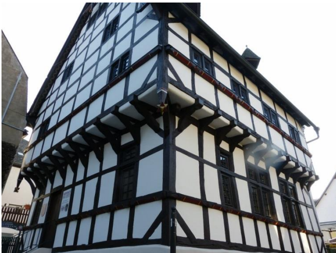
Der Abteihof St. Marien nach seiner Sanierung
